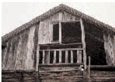
Teil eines Unterdachs von Bisele (Archiv ICMC)
