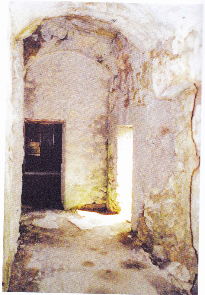
Batteriegang, rechts Eingang in die Kaserne; Foto Weiss
