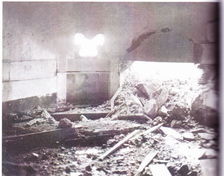
Desarmierte Geschützkasematte, gut zu sehen die Brunnenöffnung für das Gegengewicht des Geschützes; Foto KA Wien
